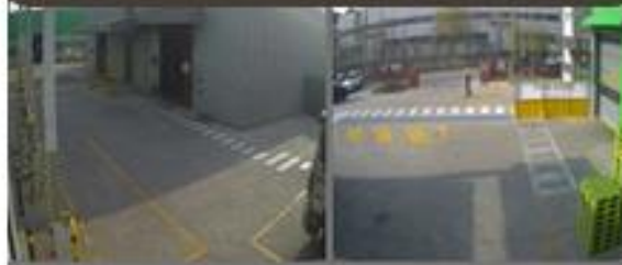
화물차/보행자 동선 도색 작업
